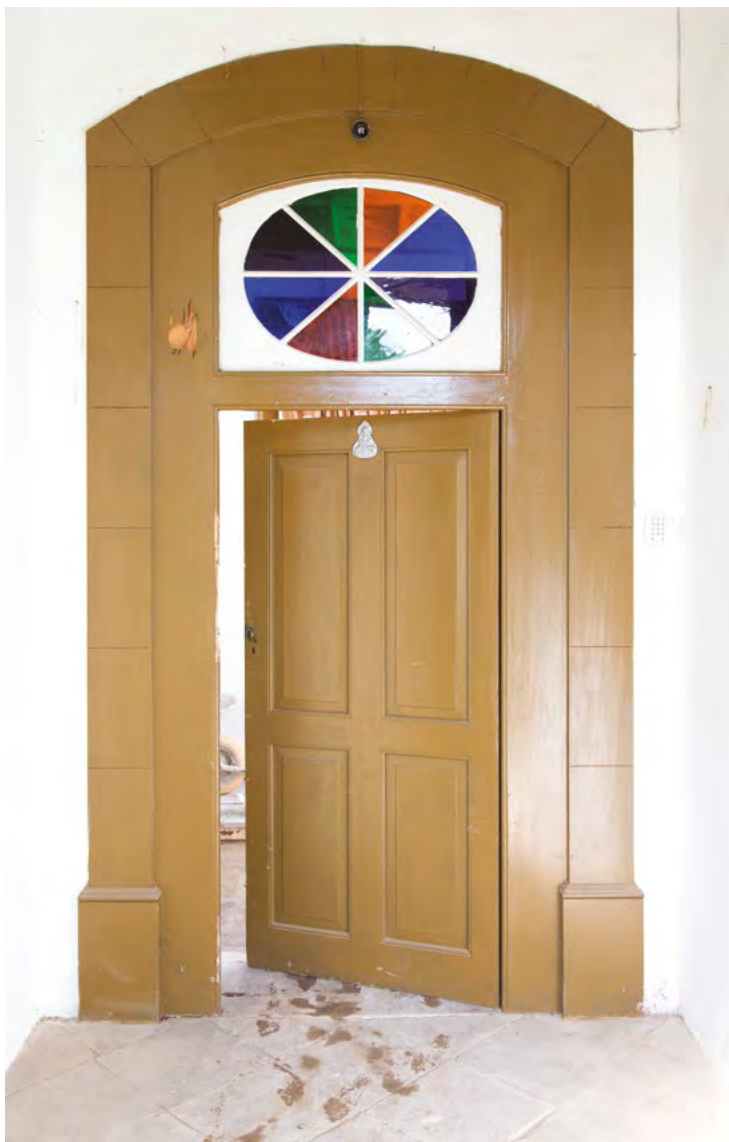
CASA DE LOS NARANJOS. PUERTA DE ZAGUÁN. FOTO: DOLORES GONZÁLEZ
